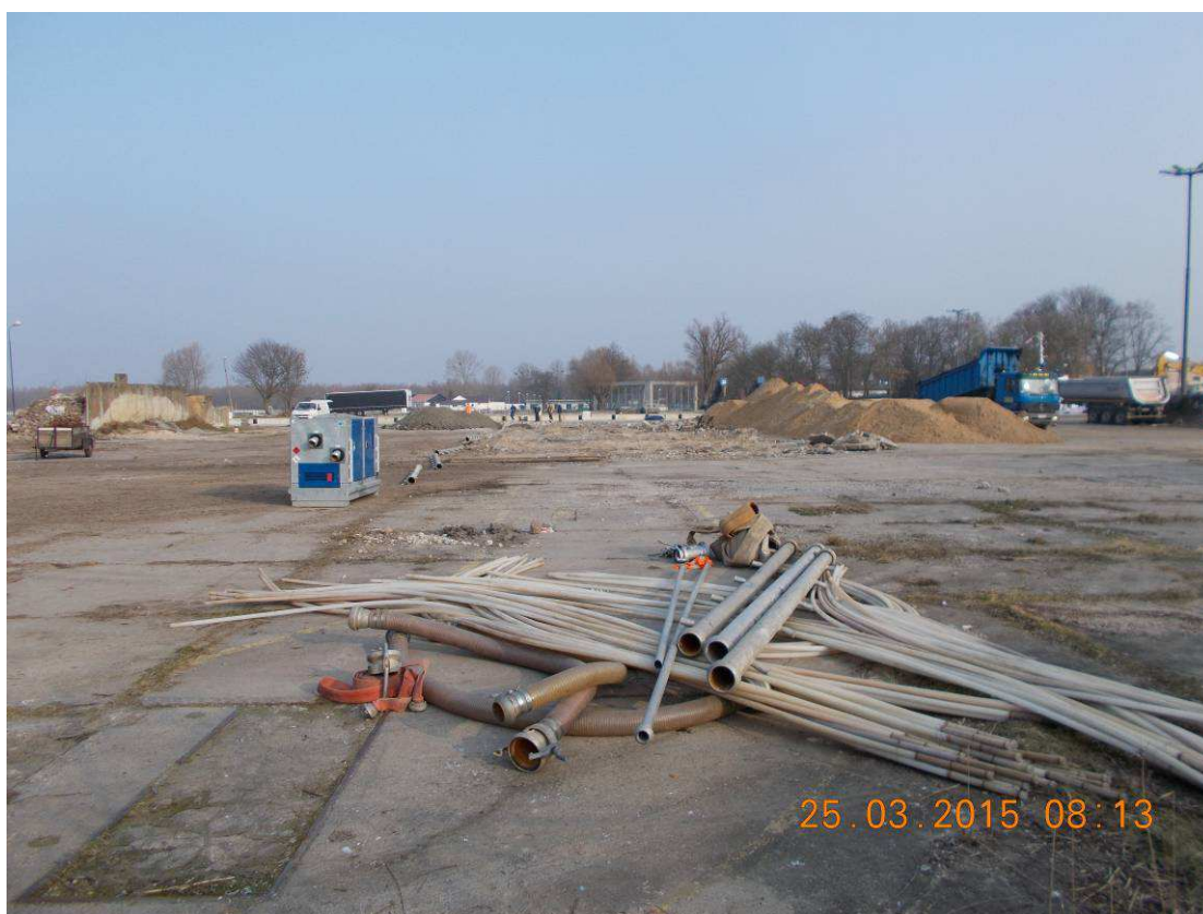
ODWODNIENIE WYKOPU ZA POMOCĄ IGŁOFILTRÓW
