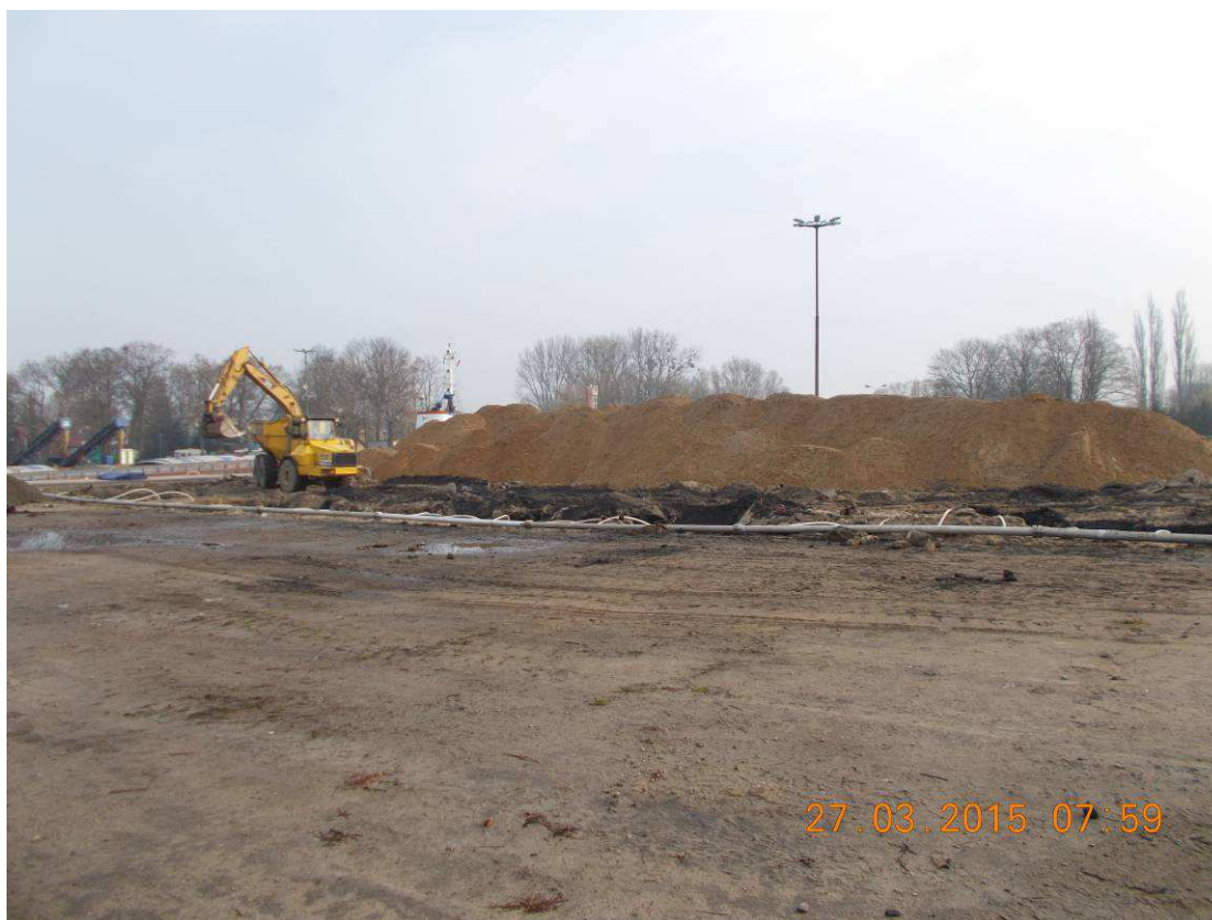
ODWODNIENIE WYKOPU ZA POMOCĄ IGŁOFILTRÓW
