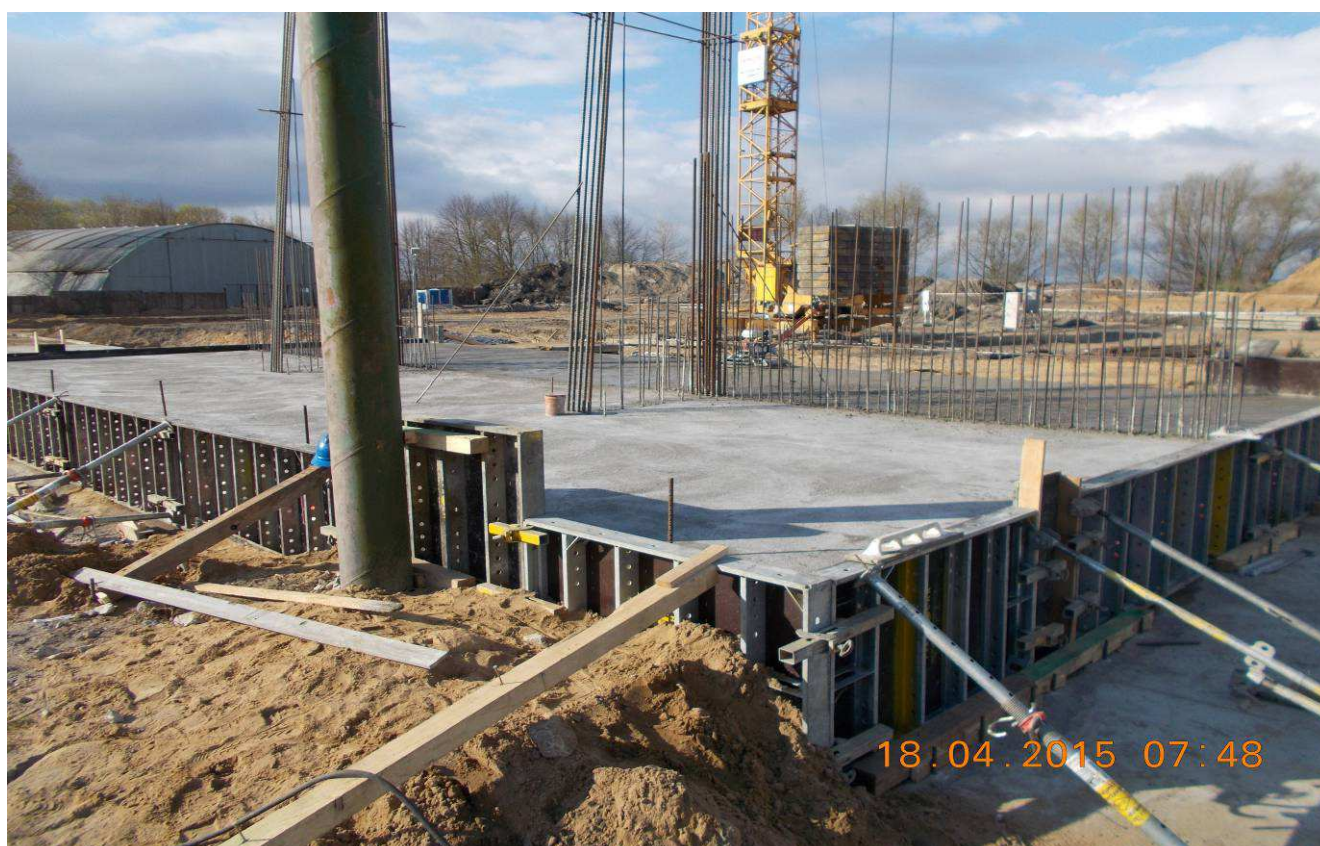
BETONOWANIE PŁYTY 1.2
