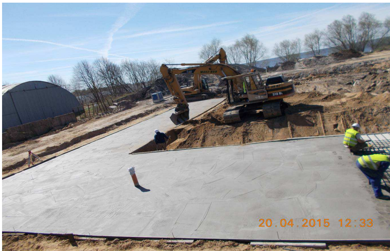
BETONOWANIE PŁYTY 1.2
